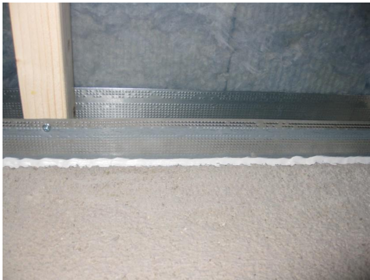
Figur 1 Exempel på lufttät anslutning mot golvkonstruktion. Plastfolien går bakom installationsskiktet, under plåtregel (som har pålimmad flexibel syllisolering) och därefter fogas plastfolien mot betongen.
